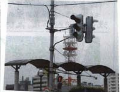
信濃川やぶらぎ塚への階段手前に設置された、ひさしつきの信号機と歩行者用は。
